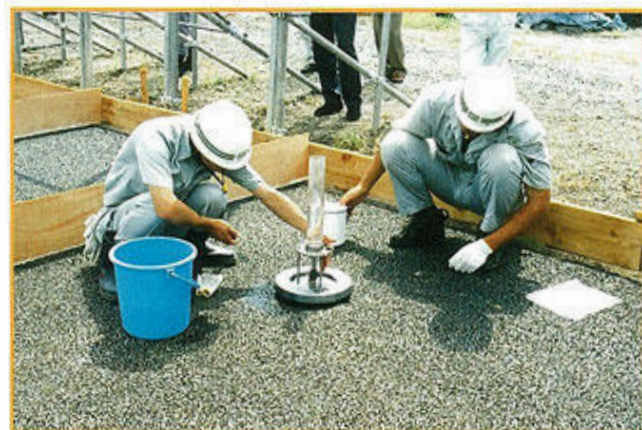
現場透水試験の状況
