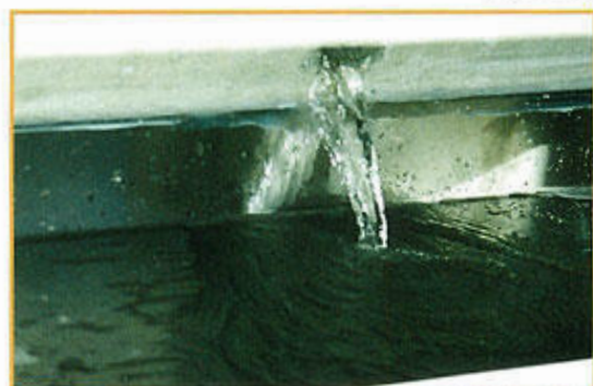
散水の排出状況
