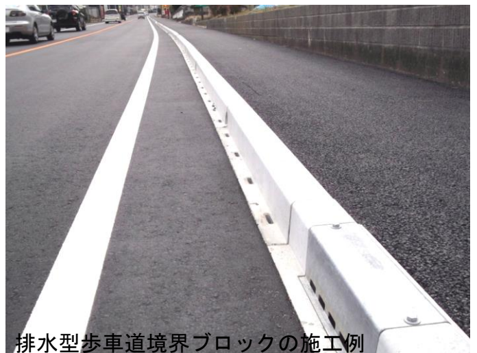
雑草の成長が殆んど確認できない暗渠形側溝と組み合わせて施工された歩車道境界ブロック
