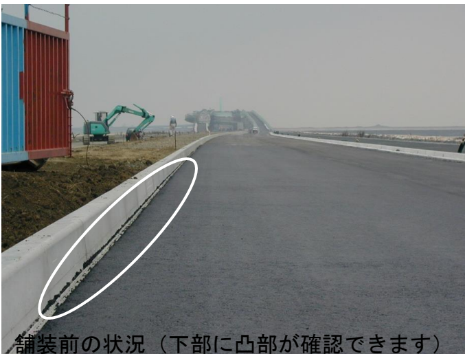
雑草の成長が殆んど確認できない暗渠形側溝と組み合わせて施工された歩車道境界ブロック
