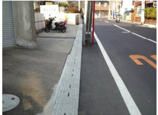
・U字溝を切断し、メイクコンフタを設置。
