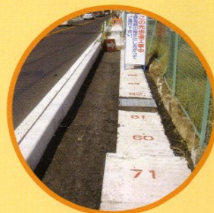
仮復旧(歩道解放)状況
