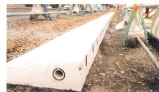
◆施工例：平成13年 国道4号線三本柳交差点改良 (国土交通省 岩手工事事務所)
